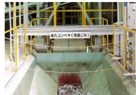
資源ごみ受入コンベヤ 収集車から搬入した資源ごみは、専用の受入ホッパへ投入されます。
