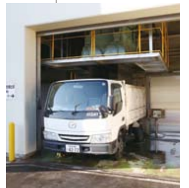
灰バンカ 灰バンカにたくわえられた薬剤処理後の飛灰は、この灰バンカより搬出車に積込まれて最終処分場へ運ばれます。
