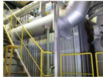
ろ過式集じん器 排ガス中のばいじんは、バグフィルタによって微細なばいじんまで完全に取り除かれます。
