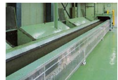
手選別コンベヤ 資源ごみよりガラス、その他を選別します。
