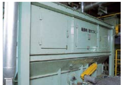
磁選機 ごみの中の鉄分を磁選機で回収します。
